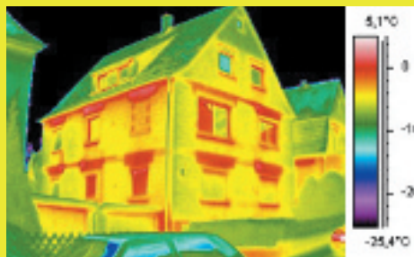
絶縁不良によるホットスポット
