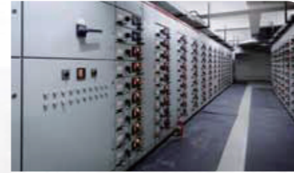
重要機器の継続的モニタリング
