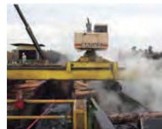
外気温度が低いと、蒸気が発生し、作業者の視界が遮られる
