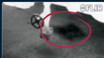
生産現場からのガス漏れを捕捉
