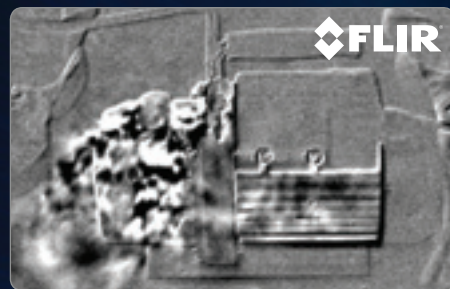
冷媒ガス漏出中のAC装置の高感度モード画像
