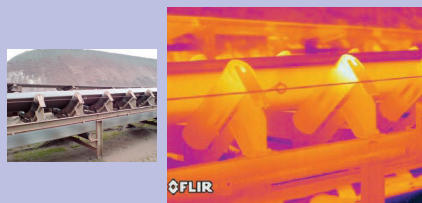
コンベアの温度監視
