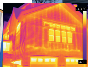
▲壁面の断熱状態確認
