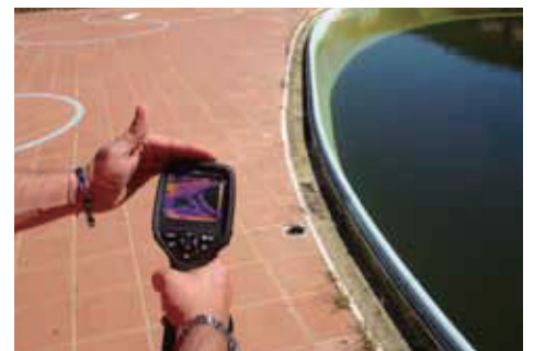
赤外線サーモグラフィFLIR E60が水漏れ箇所を鮮明に映し出している
