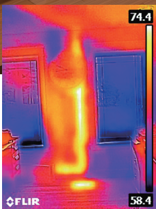
▲壁内部の配管を確認
