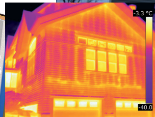
△壁面の断熱状態確認
