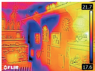
▲断熱材の有無確認
