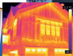
▲壁面の断熱状態確認
