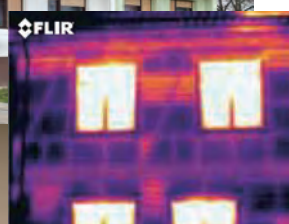
▲窓上部の断熱確認
