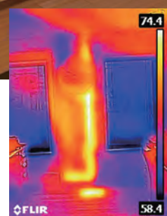
▲壁内部の配管を確認
