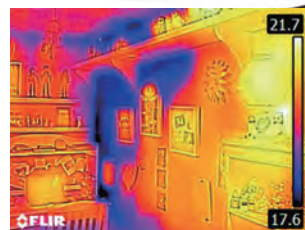
▲断熱材の有無確認
