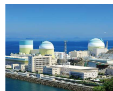
原子力発電所
